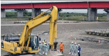
ICT土工の説明を受ける様子
