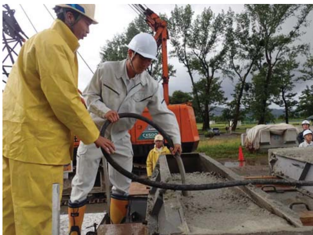
バイブレータ(φ60mm)による締固め状況
