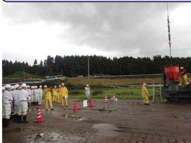
コンクリート打設状況視察
