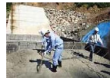
コンクリート打設体験
